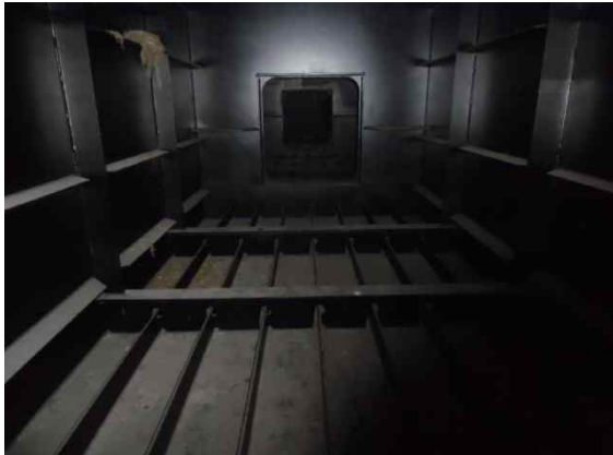
Steel Box Girder 내부 전경
