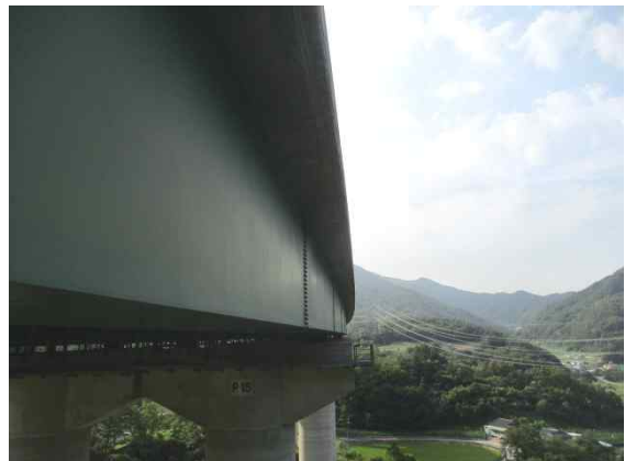
Steel Box Girder 외부 전경
