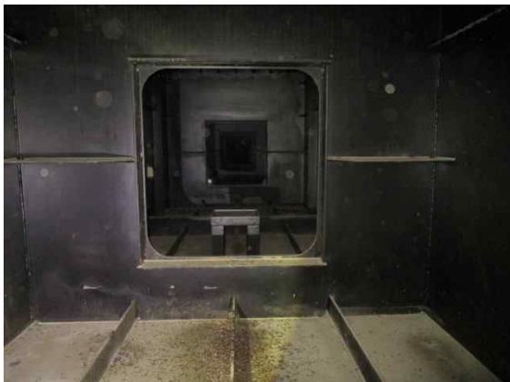
Steel Box Girder 내부 전경
