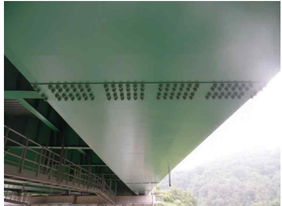
Steel Box Girder 외부 전경
